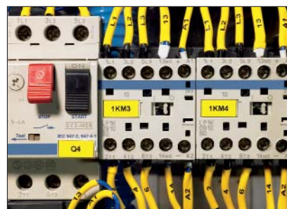
Bezhalogenowe oznaczniki termokurczliwe do nadruku termotransferowego po obkurczeniu.
