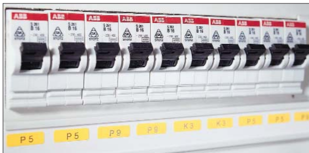
Oznaczenie aparatury łączeniowej.
